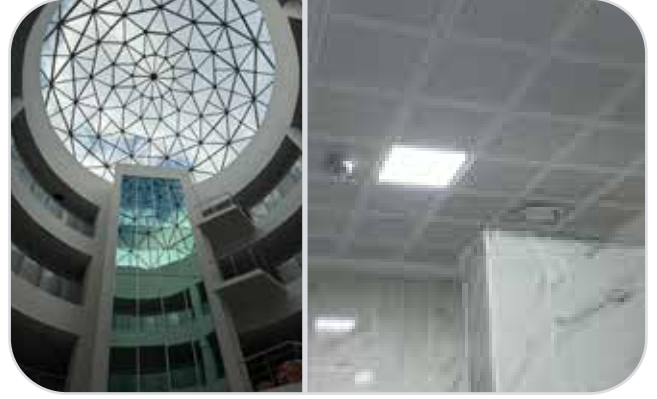
Yapımı Devam Etmekte Olan Beden Eğitimi ve Spor Yüksekokulu Binası
